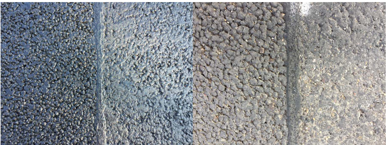
Abbildung 4: Beispielhaft links ein konservierter und rechts nicht konservierter Bereich
