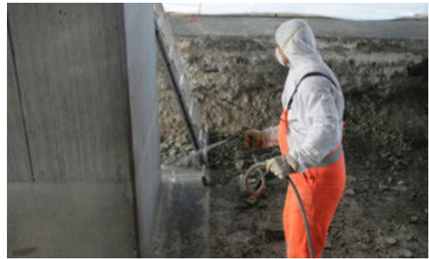
Schritt 3: Applikation des Hydrophobierungsmittels im Airless-Verfahren
