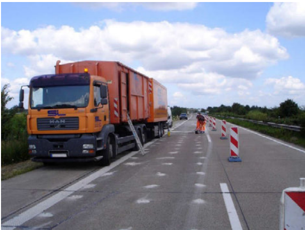
Bild 5: Bohrraster für die Injektion mit Silikatharz und sichtbares Trennmittel am Bohrloch
