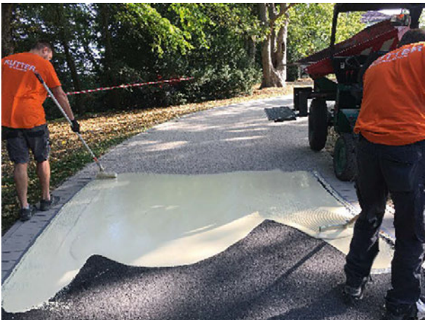
Bild 8: händischer Harzauftrag
