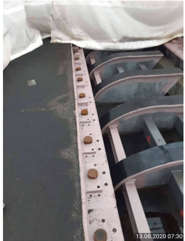
[12] Südbrücke Seite Oberwerth TBW G1
