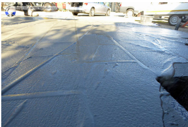
Verfugen/Einschlämmen mit Zementmörtel Abbinde-/Aushärtungszeit > 28 Tage, Nachbehandlung
