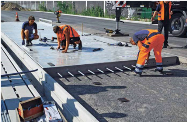
Bild 5: Verlegung Betonfertigteilen mit Dübel-Dübelkammerverbindung (Quelle: BTE stelcon GmbH)
