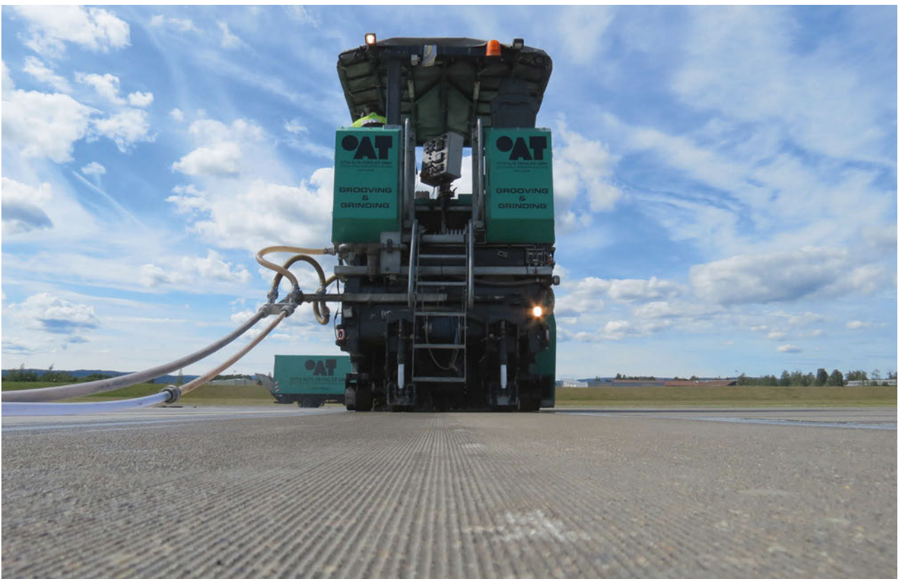
Bild 2: Oberflächenstruktur mit feinen Rillen durch Grinding
