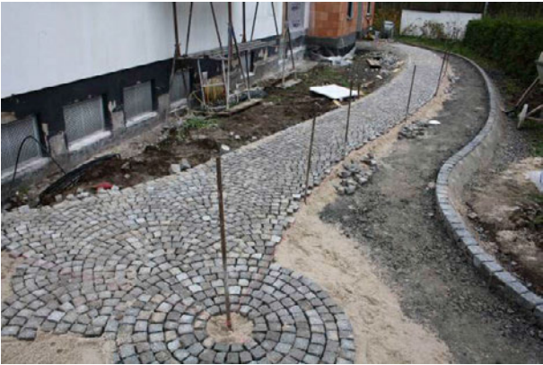
Abb. 27: Setzen Randeinfassung aus Natursteinpflaster in Beton und Platz- und Weggestaltung mit Kleinpflaster im Segmentbogen mit Rosette in Natursand gesetzt. (Foto Netzwerk Pflasterbau) [11]
