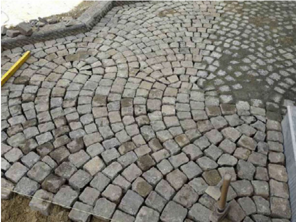
Abb. 16: Segmentbogen – Seitenanschluß – Abzweigung mit sogenanntem Kirchenfensterbogen (Foto Steinkunst Schnitzler) [11]
