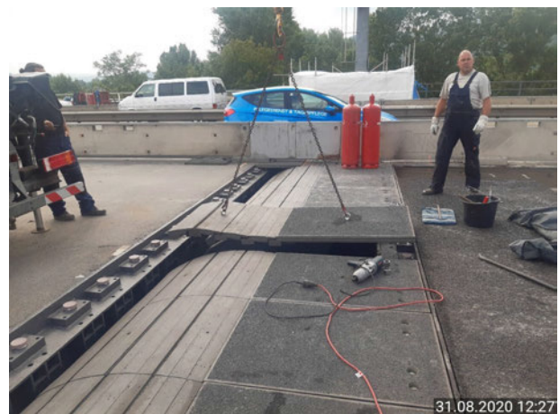
[13] Südbrücke Seite Oberwerth TBW G1
