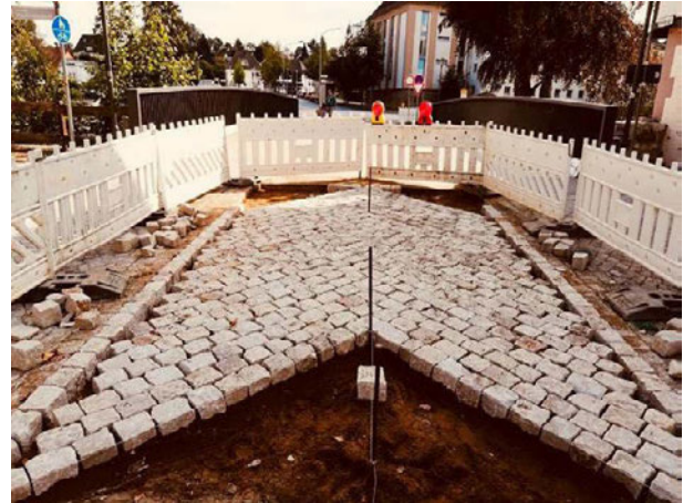
Abb. 19: Diagonal-Reihenpflaster mit Bindersteinen, Großpflaster aus Sandstein (Foto Straßenbau Beißner)
