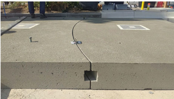
Bild 10: verlegte Betonfertigteile mit gebogener Fuge zur Lärmminimierung und einer Nut-Nut-Verbindung (Quelle: Hrvoje Prskalo, mag.ing.traff.)
