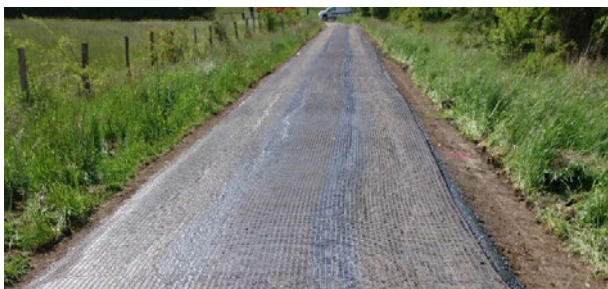
Abb. 1: Unterlage der Tragschicht -Wellingweg
