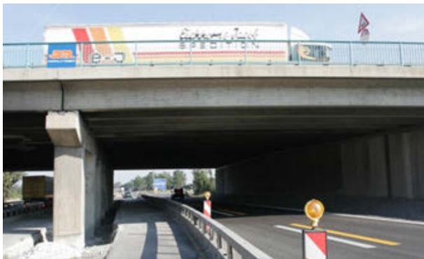
Schritt 1: Zustandsanalyse und/oder Anlegen von Probenflöchen
