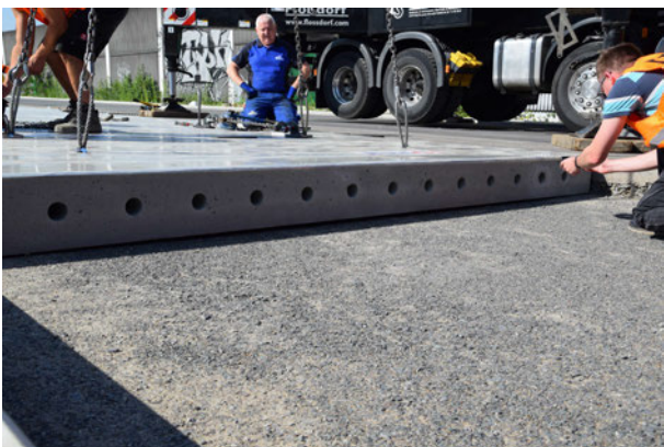
Bild 7: Verlegung Betonfertigteile mit Schiebedübelausparung (Quelle: BTE stelcon GmbH)
