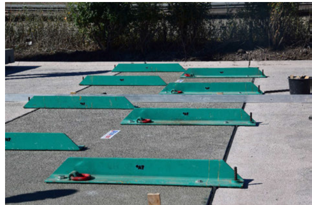
Bild 2: Traversensystem II mit Anschluß an angrenzende Fahrbahnkonstruktion (Quelle: Otto Alte-Teigeler GmbH)
