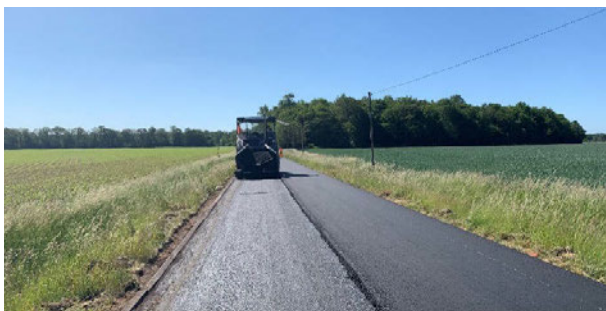
Abb. 4: Unterlage der Tragschicht und zweibahniger Einbau - Vogelsang
