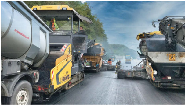
Asphalteinbau © Via6West
