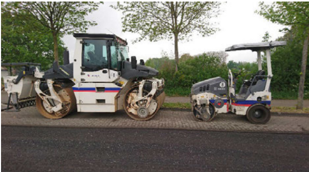
Abb. 7: Eingesetzte Tandemwalze (links) & Kombiwalze (rechts)
