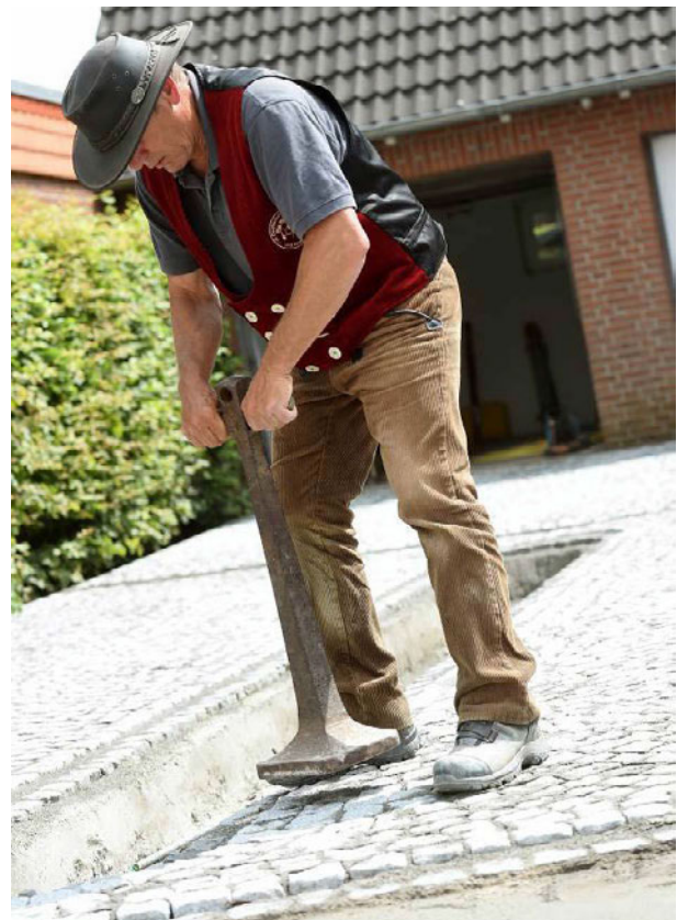
Abb. 31: Abrammung Mittelmosaikpflaster im Segmentbogen versetzt (Foto Netzwerk Pflasterbau) [11]
