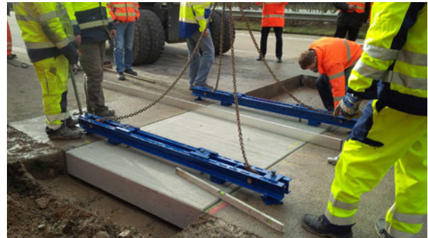
Bild 1: Traversensystem I mit Anschluß an angrenzende Fahrbahnkonstruktion (Quelle: Schorpfel GmbH)
