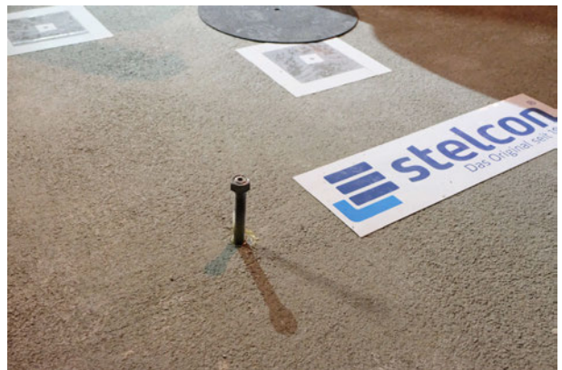
Bild 24: Justierschraube „HESTER Kombi“ zum Höhenangleich und gleichzeitigem unterpressen (Quelle: BTE stelcon GmbH)
