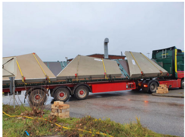
Bild 14: Anlieferung der ungleichförmigen Betonfertigteile mit einem Schräglader (Quelle: BTE stelcon GmbH)
