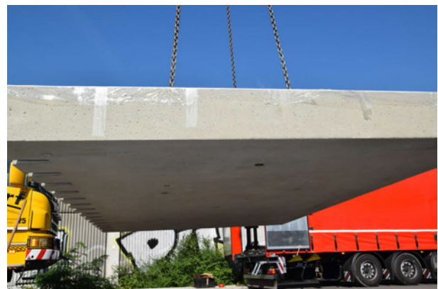
Bild: 3: Versetzen der Betonfertigteileplatten auf dem duraBAST Gelände – Betonfertigteile mit Dübelkammern (Quelle: BTE stelcon GmbH)
