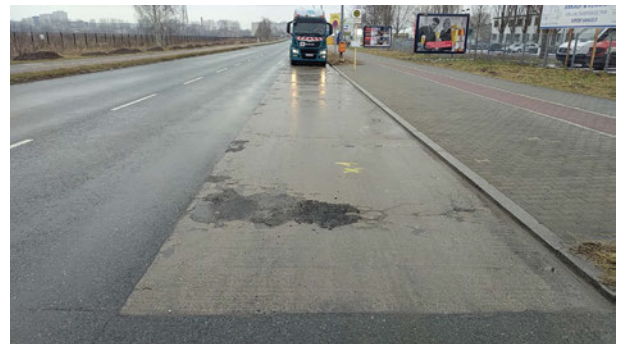
Bild 8: Örtliche Situation vor Beginn der Erneuerungsmaßnahme (Quelle: Hrvoje Prskalo, mag.ing.traff.)
