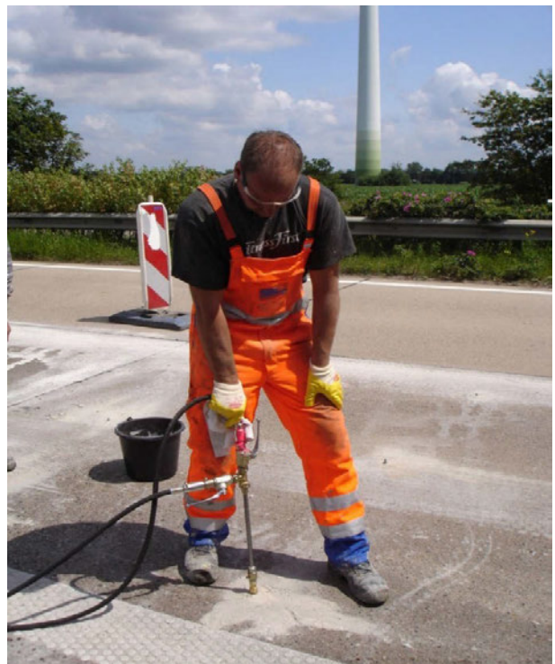
Bild 7: Injektion des Flüssigkunststoffes unter die Betonfahrbahn
