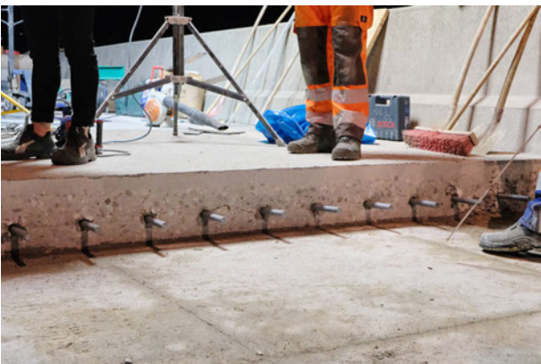
Bild 21: Einsetzen der Verschiebedübel in die vorhandene Fläche (Quelle: BTE stelcon GmbH)
