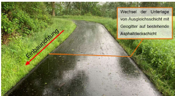
Abb. 3: Wechsel der Tragschichtunterlage - Hunnebeckweg (Hülshoffstraße)
