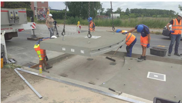
Bild 9: Verlegen der Betonfertigteile mit dem „HESTER Kombi“ (Quelle: Hrvoje Prskalo, mag.ing.traff.)
