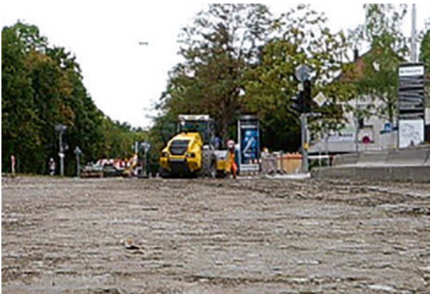
Bild 4: Die verfestigte Schicht vor dem Asphalteinbau.
