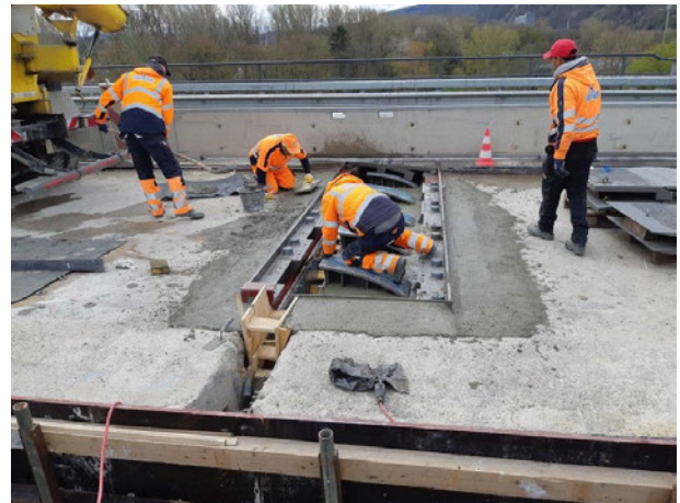
[16] Betonage der neuen Übergangskonstruktion
