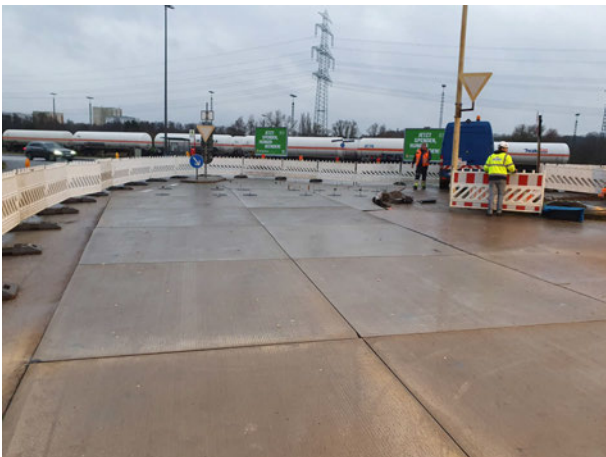
Bild 17: Verlegter Flächenbelag mit Betonfertigteilen – Vorbereitet zum verschließen der Flächenfuge (Quelle: BTE stelcon GmbH)
