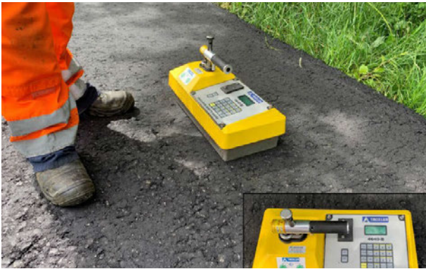
Abb. 8: Messung des Verdichtungsgrades mit einer Isotopsonde (Troxler-Sonde)
