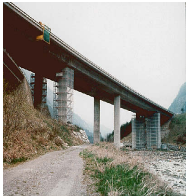
Abbildung 15: Für die Ökobilanzierung einer Instandsetzung und einer Tiefenhydrophobierung betrachtete Brücke der Gotthard-Autobahn
