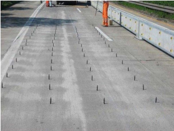
Bild 4: Bohrschema und Lamellenschlagpacker
