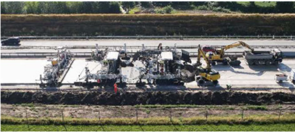
Betoneinbau © ViA VSN
