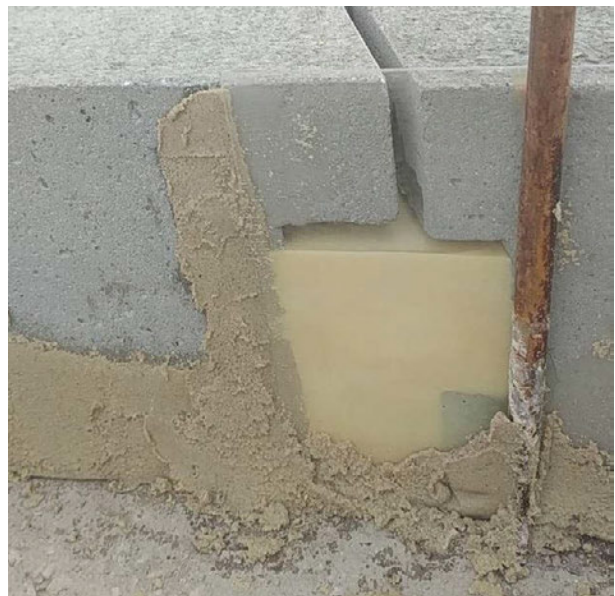
Bild 11: Füllstand der Unterpressung mit dem Silikat-harz (Quelle: Hrvoje Prskalo, mag.ing.traff.)
