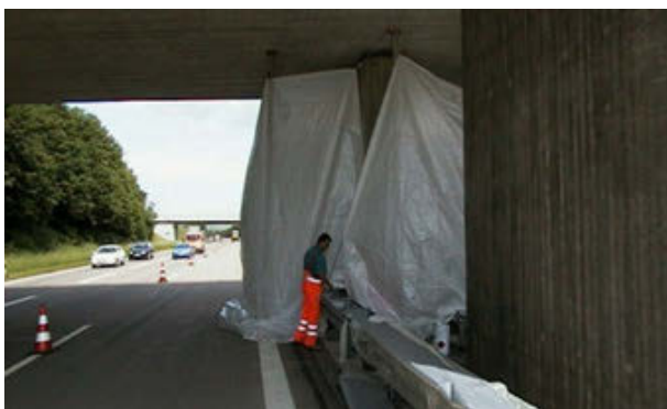
Schritt 2: Schutz der vorbeifahrenden Autos und Verkehrsflöchen
