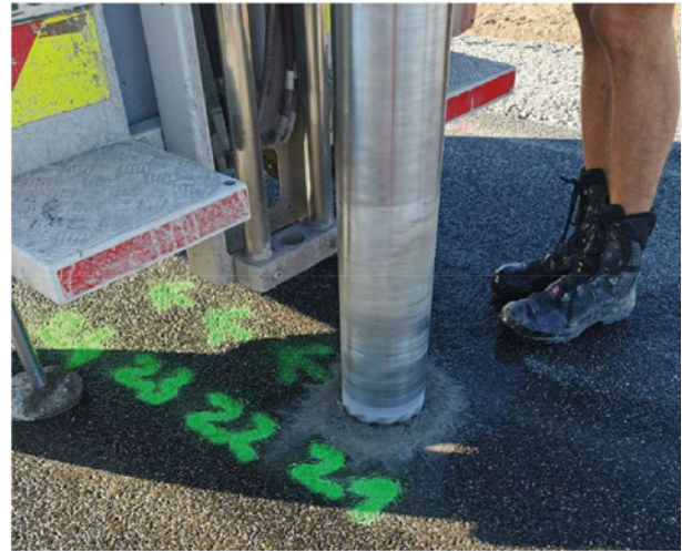
Bohrkernentnahme © PrüfARGE ABPI/IBE GbR
