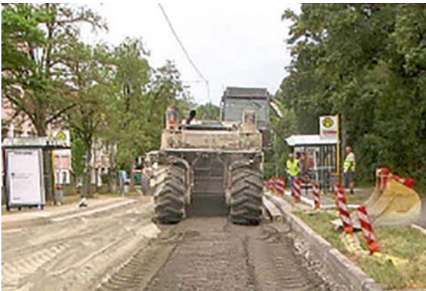
Bild 3: Mischen des Spezialbindmittels.
