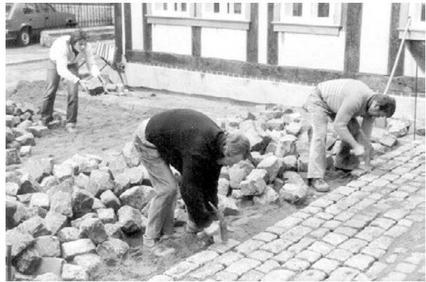
Abb. 28: Setzen Großpflaster in Reihe mit sortierten Steinbreiten (Foto Straßenbauer-Innung Braunschweig)
