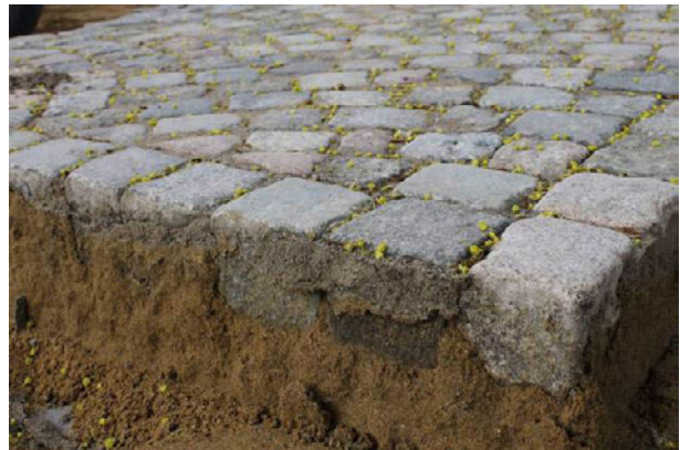
Abb. 7: Natursteinpflaster in Natursand gesetzt und obere Fugenfüllung mit Steinmehl Diabas (Foto Steinkunst Schnitzler) [11]
