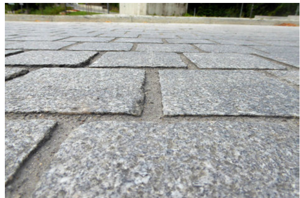
Vergleich herkömmliche Bauweise zu LTR-Verlegung – Pflaster-Terrazzo
