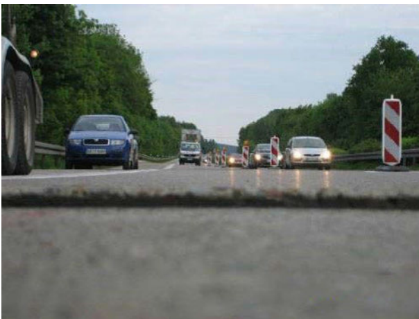
Bild 1: vertikaler Plattenversatz
