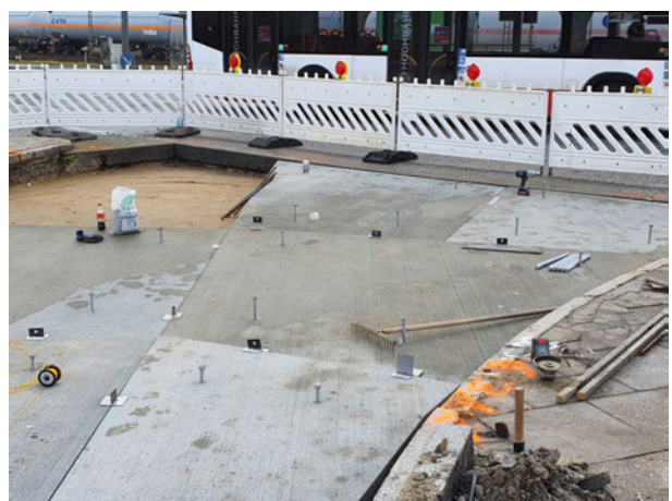
Bild 15: Verlegte Betonfertigteile in der Fläche – vorbereitet zur Höhenjustierung mittels Stellschrauben „HESTER Kombi“ (Quelle: BTE stelcon GmbH)
