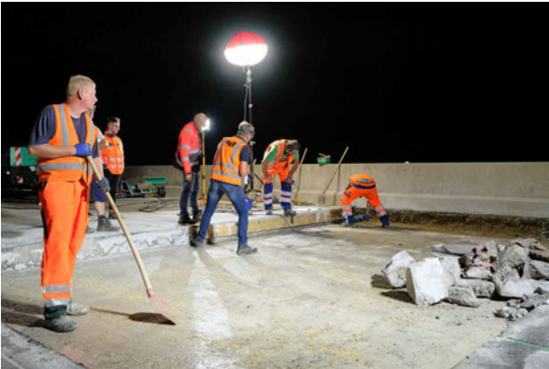
Bild 20: Vorbereiten der Sanierungsfläche – Anbringen der Dübelbohrungen (Quelle: BTE stelcon GmbH)
