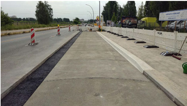
Bild 12: Verlegter Flächenbelag mit Betonfertigteilen – Vorbereitung zur Anarbeitung an den vorhandenen Flächenbelag (Quelle: Hrvoje Prskalo, mag.ing.traff.)
