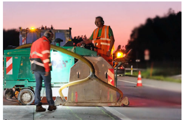
Bild 19: Trennschnitte gemäß Planvorlage (Quelle: BTE stelcon GmbH)
