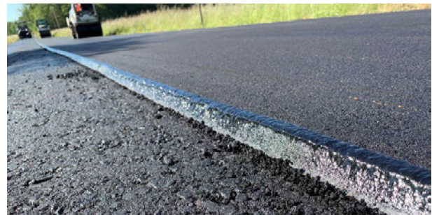
Abb. 5: Ausführung der Längsnaht zwischen den Deckschichtbahnen – Vogelsang
