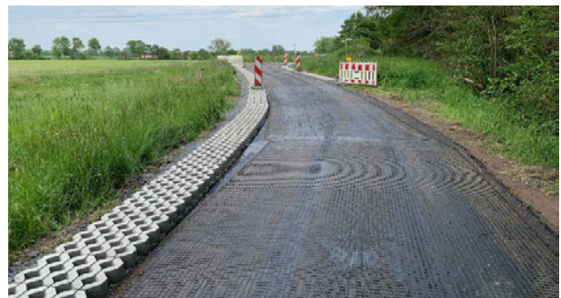
Abb. 2: Unterlage und Rasengittersteine - Derßenbrockstiege / Schmitthausweg
