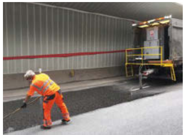
Bild 6: maschineller Harzauftrag
