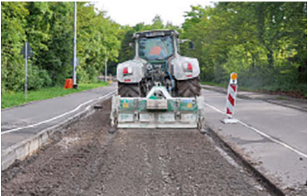
Bild 2: Homogenisierter und gebrochener Straßenaufbau in Stuttgart.
