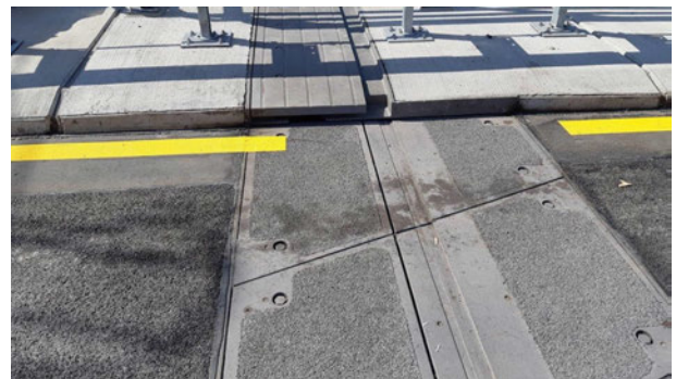
[17] Neue Übergangskonstruktion mit Asphaltanschluss
