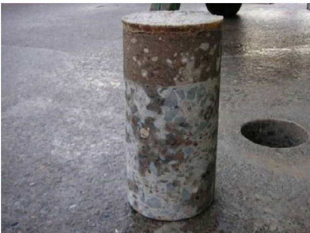
Bild 11: Bohrkernentnahme zur Qualitätssicherung
