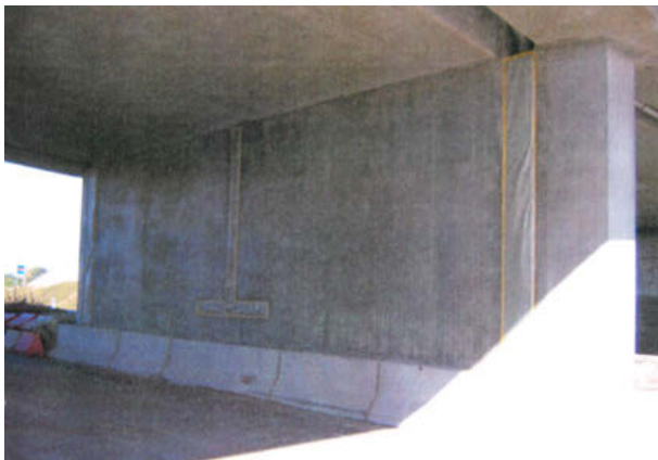
Abbildung 10: Brückenbauwerk A99 BW 0/5 – Bohrkernentnahmestellen (oben) und Aussparung der Tiefenhydrophobierung bei der Applikation (unten)
