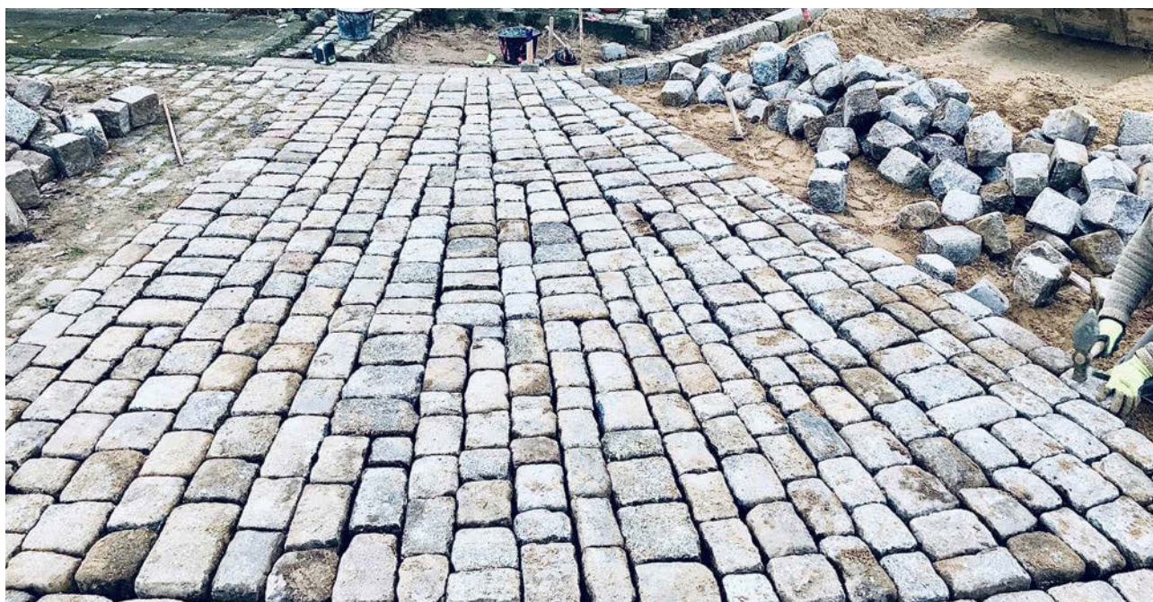
Abb. 1: Naturstein-Reihenpflaster mit unterschiedlichen Steinbreiten im Kurvenbereich mit Aufweitung in Keilform (Foto Straßenbau Beißner)
