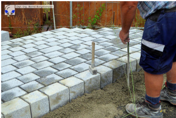
Versetzen von 5-seitig kugelgestrahlten Granitsteinen, Oberseite gesägt.
