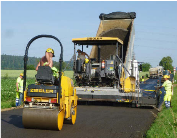
Abbildung 1: Einbau des ORRAP-Materials mit einem Straßenfertiger
