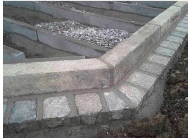
Abb. 26: Setzen Naturbordstein und Verfugen der Randeinfassung mit 1-zeiliger Rinne (Foto Schnitzler) [11]
