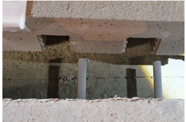
Bild 23: Verbindung Dübel – Dübelkammer (Quelle: BTE stelcon GmbH)
