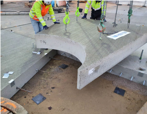
Bild 16: Einsetzen eines Betonfertigteil – Aussparung zur Anpassung an vorhandene Verkehrsbauteile (Quelle: BTE stelcon GmbH)
