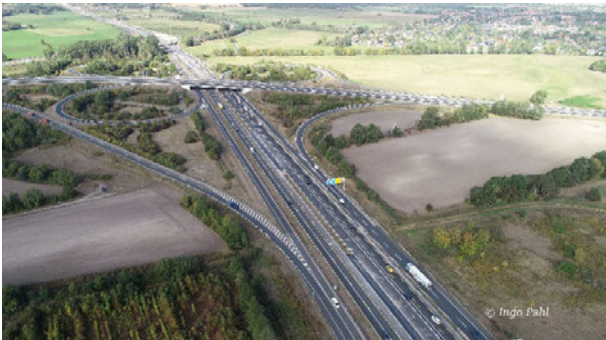
Luftaufnahme Havellandautobahn (Bild: Ingo Pahl)
