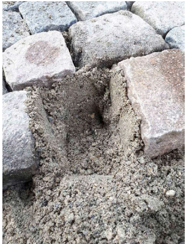
Abb. 29: Kleinpflaster bis zu \frac{2}{3} seiner Höhe in Natursand versetzt (Foto Steinkunst Niesen) [11]
