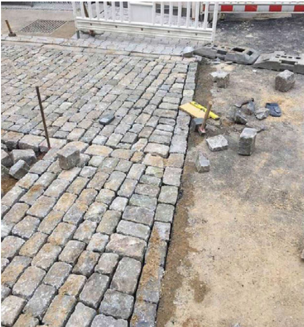
Abb. 30: Setzen von Großpflaster in Reihe mit sortierten Steinbreiten mit Zuarbeitung – Verhau und Reihenverziehung, da schräger Anschluss an Bestandsfläche. (Foto Straßenbau Beißner, Bielefeld) [11]
