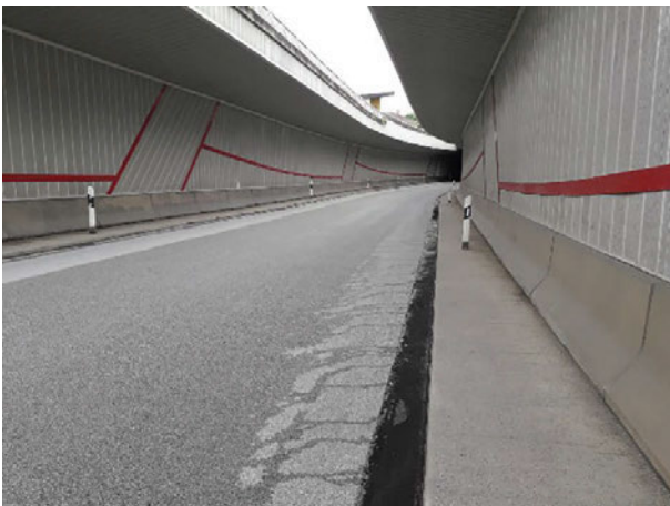
Bild 1: optische Aufhellung Trogbauwerke
