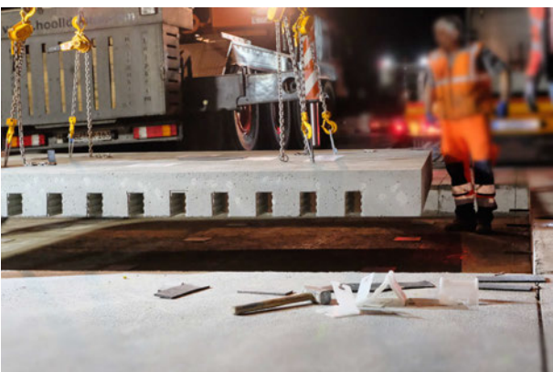
Bild 22: Verlegen der Betonfertigteile mit den Dübelkammern (Quelle: BTE stelcon GmbH)
