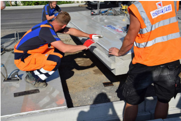
Bild 6: Verlegung Betonfertigteile mit Nut-Feder-Verbindung (Quelle: BTE stelcon GmbH)
